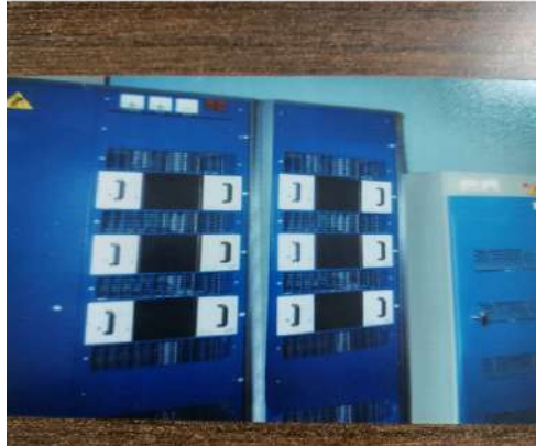
Тоон системийн станцуудын зай тэжээлийн шулуутгах байгууламж
