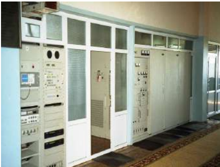
Япон Улсын буцалтгүй тусламжаар байгуулагдсан NEC компаний HFB-8040, HFB-8047 загварын 10 ба 50 кВт хүчин чадалтай богино долгионы нэвтрүүлэгч
